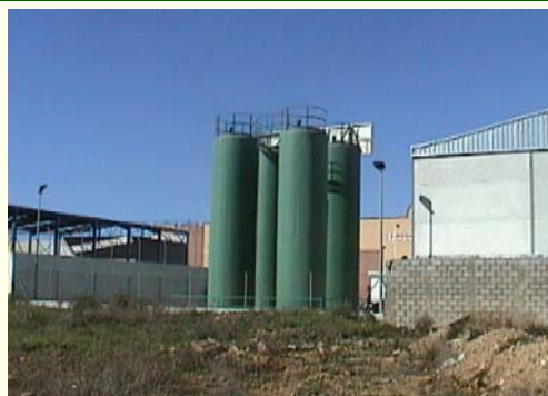
Fábrica de hormigones preparados
